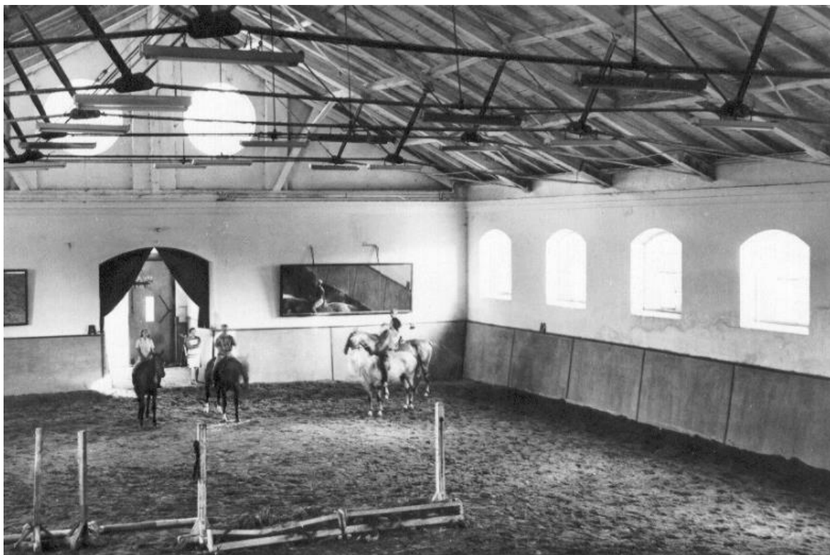
A fedett lovarda belső tere, az 1967-es helyreállítás után az eredeti fedélszékkal (forrás: BFVT engedélyezési- és kiviteli terve, 2003. Építész: Kugler Katalin)
