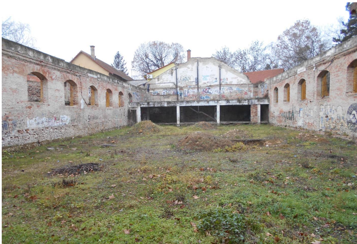
A fedett lovarda belső tere a vasbeton galéria maradványával, 2018. december
