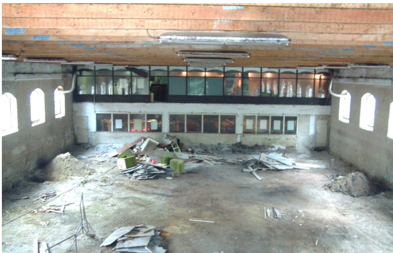
A fedett lovarda belső tere, a galériával, 2003. (forrás: BFVT engedélyezési- és kiviteli terve, 2003. Építész: Kugler Katalin)
