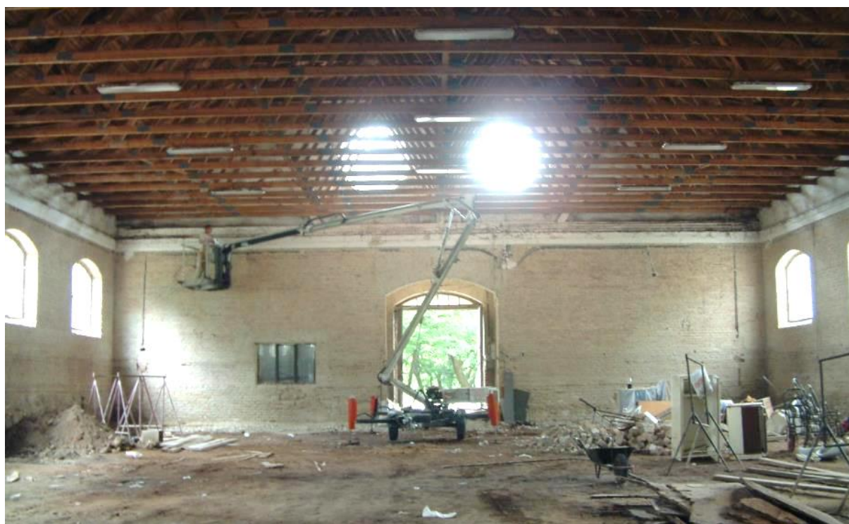
A fedett lovarda belső tere, dél felé, 2003. (forrás: BFVT engedélyezési- és kiviteli terve, 2003. Építész: Kugler Katalin)
