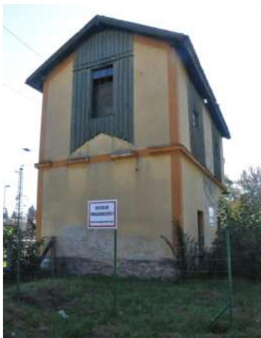
68. ábra A vasútállomásnál lévő vízház
