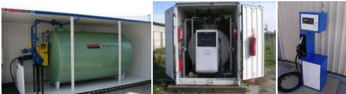
213. ábra Képek a konténeres gázolaj töltőállomás kialakításra
