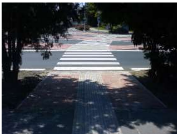
228. ábra Süllyesztett szegély és rámpa, taktilis jelzésekkel gyalogátkelőhelynél (példa)
