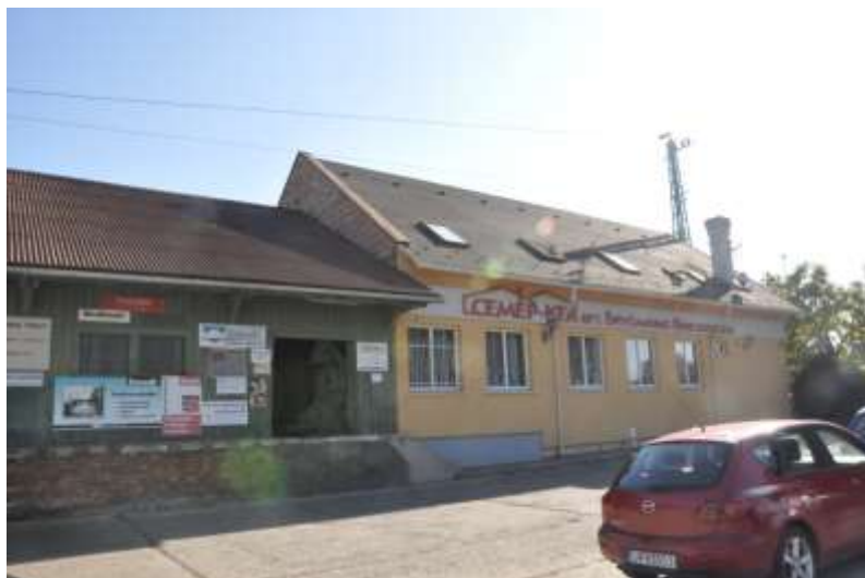
70. ábra Az áruraktárhoz épült téglaszerkezetű toldaléképület
