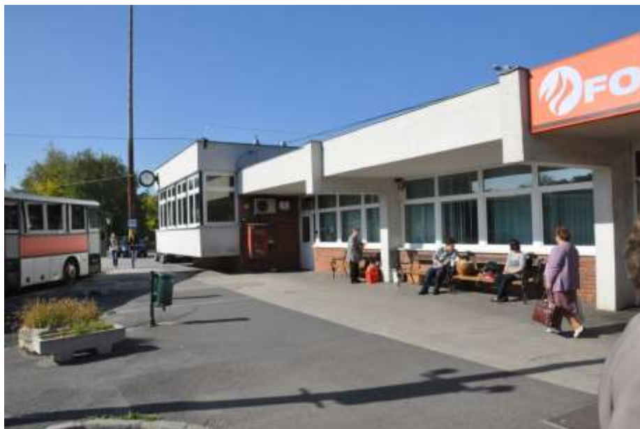
58. ábra Az autóbusz állomás dél-nyugati épületrésze
